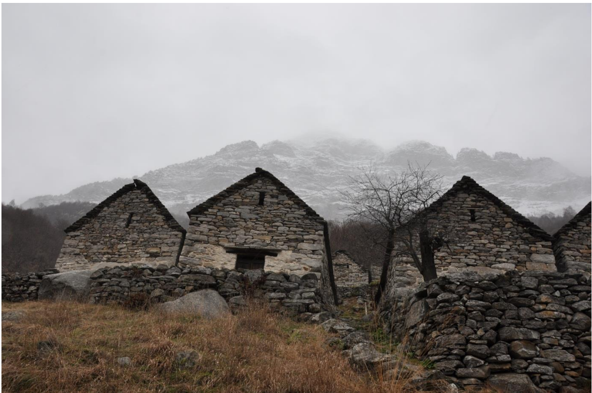
Abb. 2 Ar Cisterna mit der Südwestwand der Föpia
